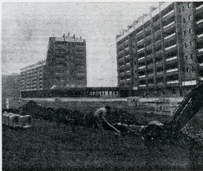
Il cantiere di via Bellarmino contiguo all'area dove dovrebbe sorgere il Ticinello
